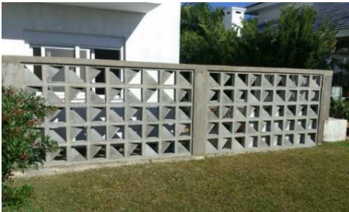
Figura 8 - Cobogó de concreto.
