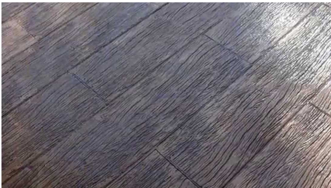
Figura 17 - Concreto Estampado de Madeira
